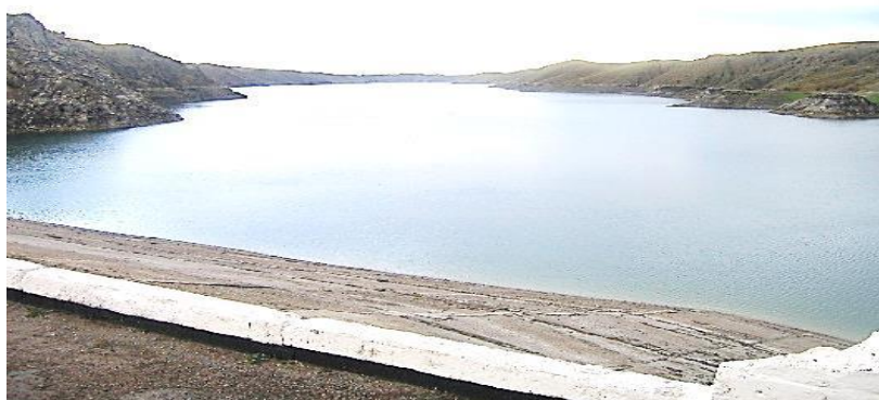
Рисунок 1- Верхний бьеф Куртинского водохранилища
