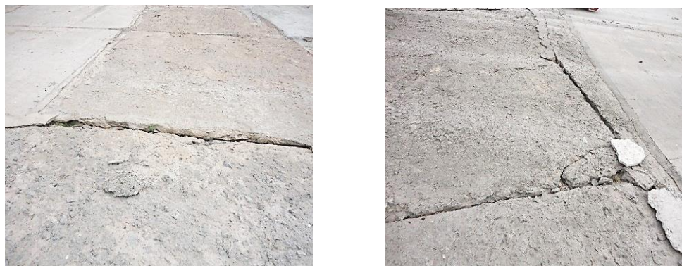
Рисунок 2 - Крепление верхового откоса плотины монолитными плитами
